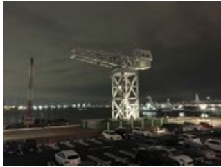
ハンマーヘッドクレーン
